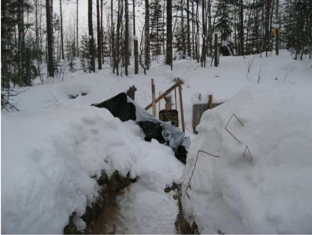
Taulu 1 oli suojattu. Vain yläneliö oli ilman suojaa...
